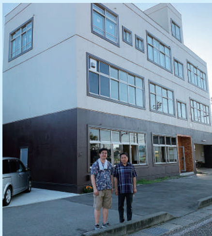
内装工事中の新しい新潟教会
